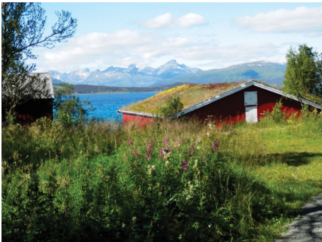
Obr. 2.1. Travní porost na střeše objektu University of Tromsø v severním Norsku (foto Miloš Zapletal).
